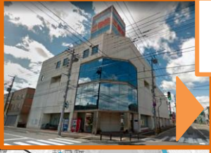
百貨店撤退後の空きビルをリノベーションし、複合施設化
